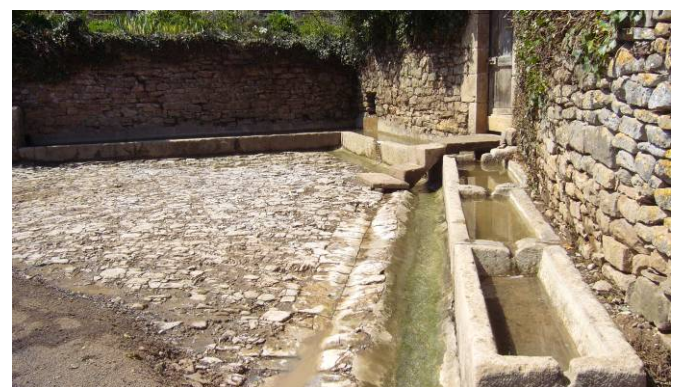
La fontaine du Riou à Gabriac une fois remise en état.
