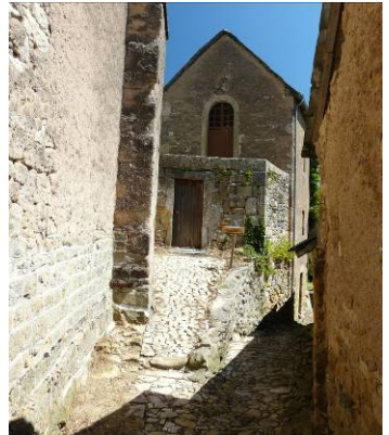
Nettoyage d'une ruelle pavée à Ceyrac
