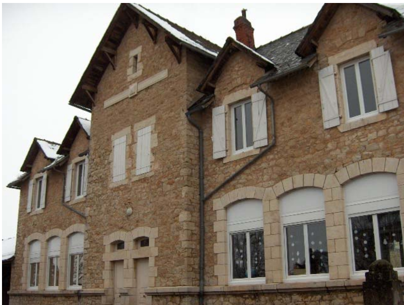
Le bâtiment scolaire avec ses nouvelles menuiseries.
